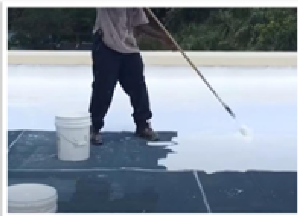
Apply Primer & EnerFlex SP 300
