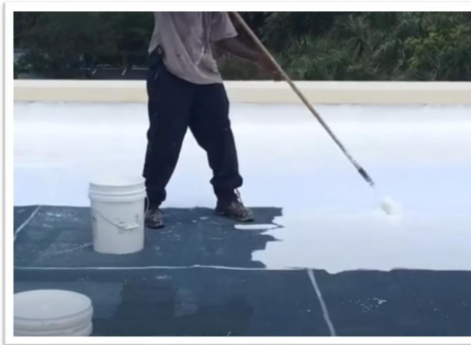
Apply Primer & EnerFlex SP 300
