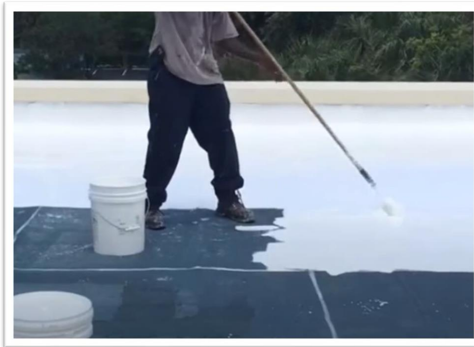
Apply Primer & EnerFlex SP 300
